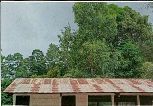
Foto1: Cambio de lámina y estructura de techo.
